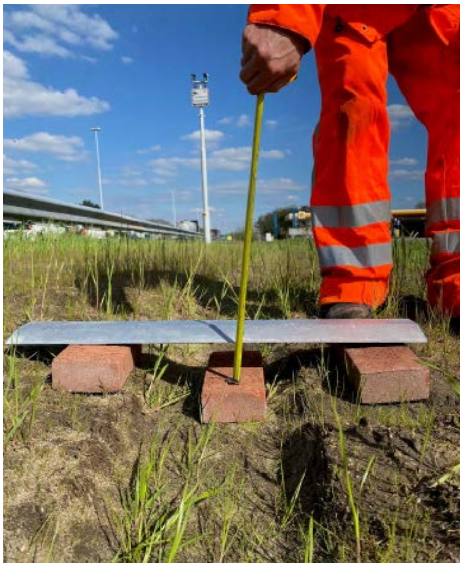
▲ Meten van daadwerkelijke insporingsdiepte na aanleg van de berm.
