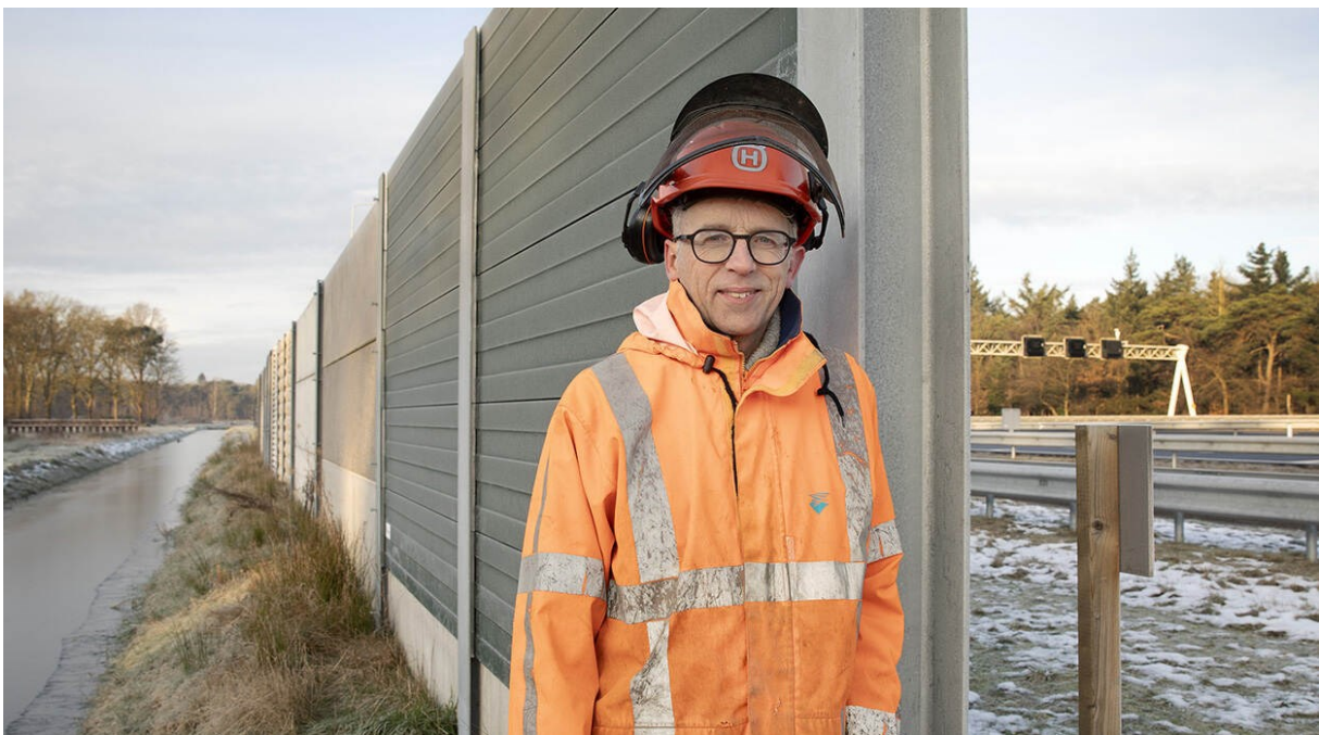
Mosbetongeluidsschermen langs de A58: duurzaam en circulair!
