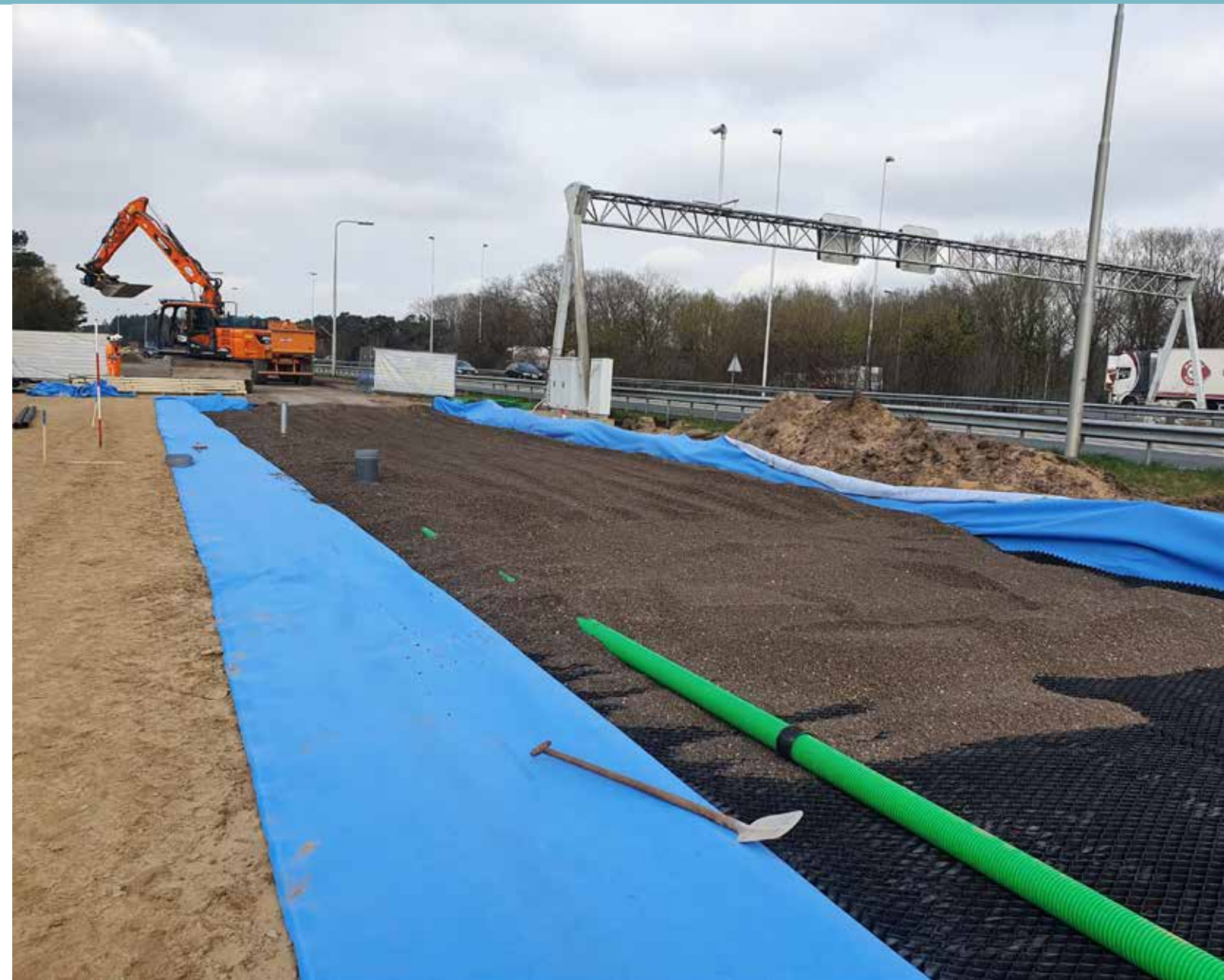
Opbrengen van het AquaBASE-materiaal voor de waterbergende wegfundering bij InnovA58. (Foto: AquaBASE)
