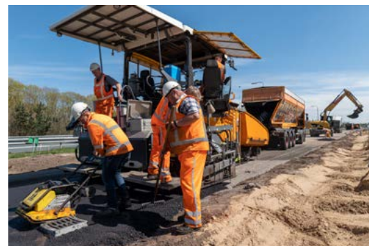
Onder- en tussenlaag asfalt KonwéCO 2
