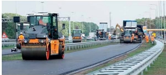
Het aanbrengen van het asfalt voor de Innovatiestreek is zonder uitstoot van CO 2 gebeurd.
